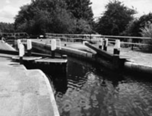
ごく一般的なロック。この水門を両側から閉めることで水を溜め、水位を上げる
