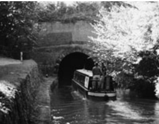
トンネルに入っていくナロウボートの人たち。歩行者はトンネルの上の森や草原、あるいは普通の道路を歩くことになる
