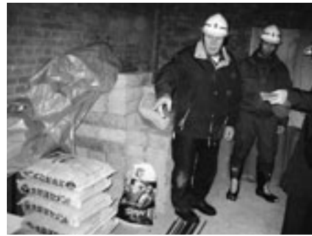
窯組み立ての資材を確認
