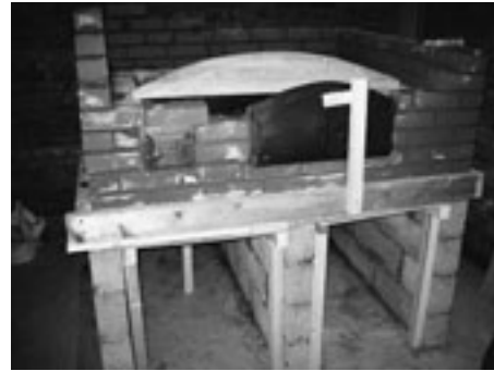
れんが倉庫内で組み立て中のパン窯
